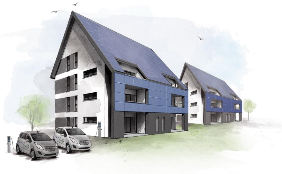
↗ Abb. 4: Miete mit Energieflat: Zwei vermietete energieautarke Mehrfamilienhäuser mit je 7 Wohneinheiten in Cottbus, Baujahr 2018, Solartechnik auf dem Dach und an den Balkonen erreichen zwischen 65 und 77 solare Deckung bei Strom und Wärme. Der Vermieter bietet dem Mieter für mehrere Jahre eine Pauschalmiete an, in der Wohnen, Wärme und Strom als Flatrate bereits enthalten ist.
