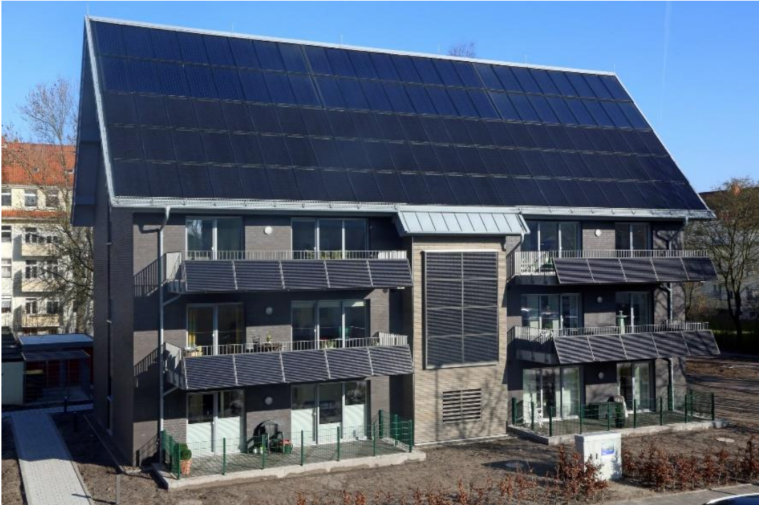
Abb. 7: Miete mit Energieflat: Ein vermietetes energieautarkes Mehrfamilienhaus mit je 6 Wohneinheiten in Wilhelmshaven, Fertigstellung 2018. Solartechnik auf dem Dach und an den Balkonen mit Energiespeicher erreichen etwa 70 Prozent solare Deckung am Strom- und Wärmebedarf. Der Vermieter bietet dem Mieter für 10 Jahre eine Pauschalmiete an, in der Wohnen, Wärme, Strom und E-Mobilität als Flatrate bereits enthalten ist.
