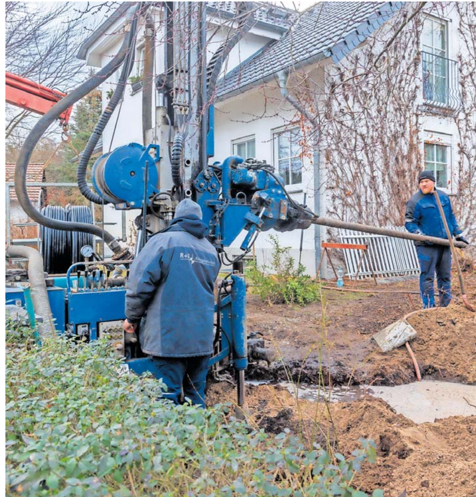
Eine Erdwärmehohrung für die Umstellung auf klimaneutrale Heizungen.
